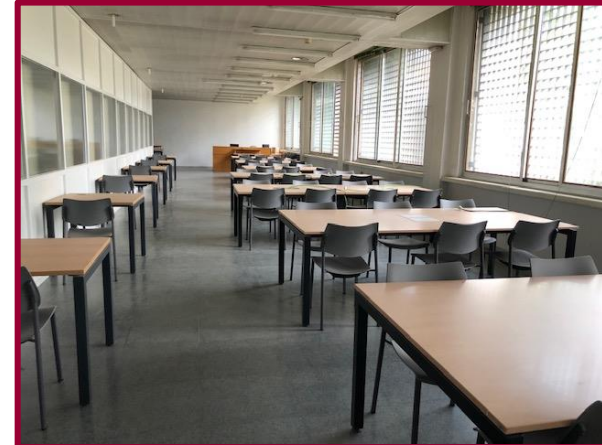
Sala de lectura (en obras)
