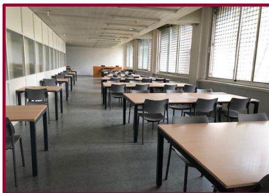
Sala de lectura (en obras)
